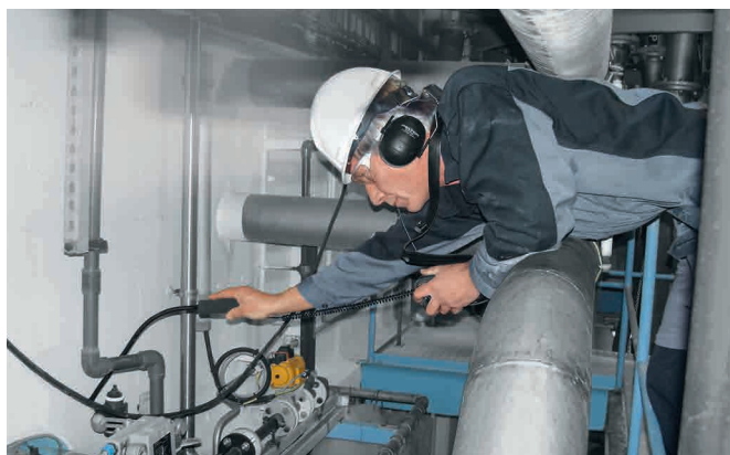
Localización de fugas en toda la fábrica, en Koog aan de Zaan. Las fugas localizadas generaron más o menos el 8% del total de los costes de aire comprimido.
