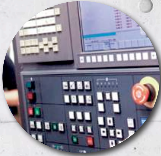
Automação e controlo
